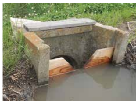
協力農家に配布している「せき板」。雨を緩やかに流すため、V字型の切り口が開けられている
